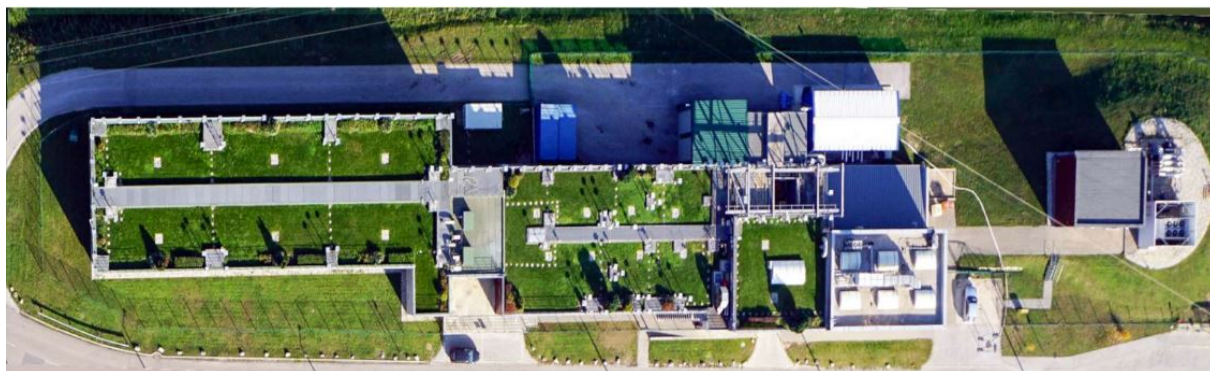
A 2117/57 hrsz-ú telken meglévő zöldtetős szennyvíztisztító műtárgy felülnézeti képe
