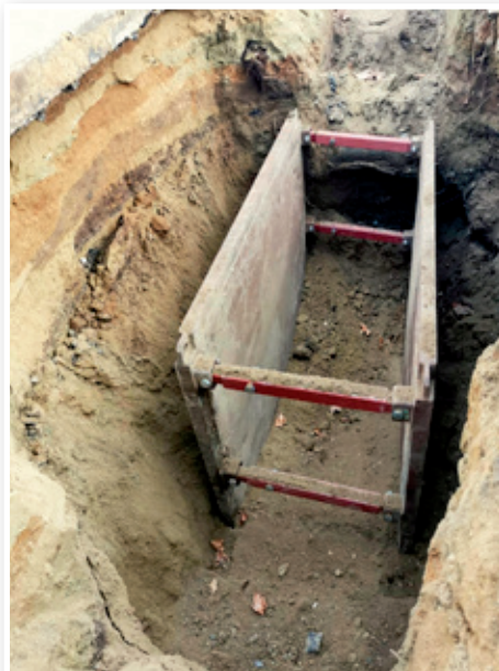
Jól látszik a talajrétegek omlékony-sága – a képen még csak 2 méter mély volt az árok
