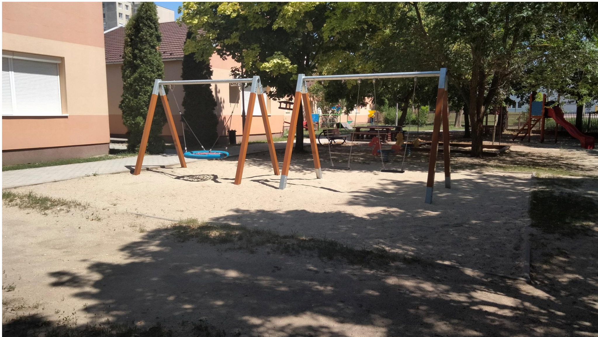
Oroszlány, Táncsics Mihály óvodában öntött gumiburkolat építése
