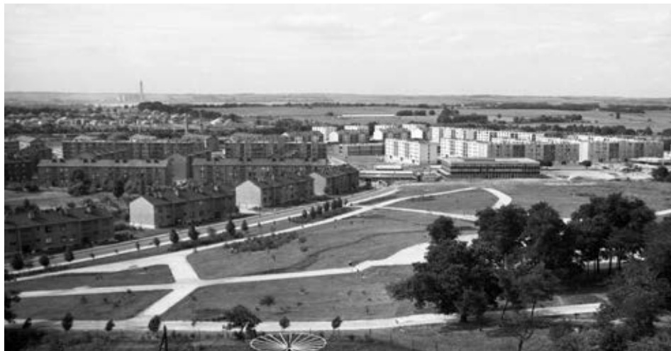
Kilátás a víztornyóból a Mészáros Lajos utca - Rákóczi Ferenc út kereszteződése felé, középen a Városháza. (1967) / Forrás: FORTEPAN / MAGYAR RENDŐR
