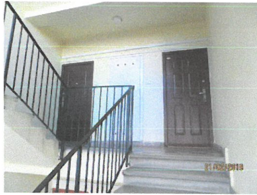
Lakás bejárati ajtó
